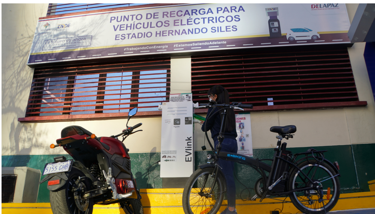
Foto: Punto de recarga monofásico (Foto DELAPAZ)
